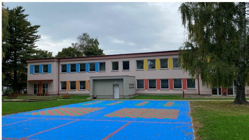
Obr. 8: Mateřská škola Budovatelů (zdroj: internetové stránky instituce).
